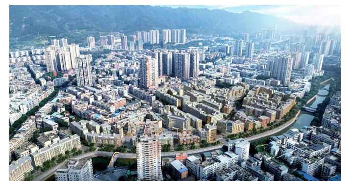
新大正璧城街道老旧小区改造项目（图片来源网络）
