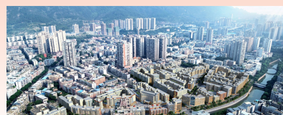
重庆市璧山区老旧小区改造项目
