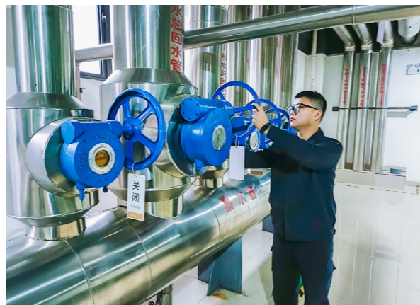
物业工程师检修工程设备
